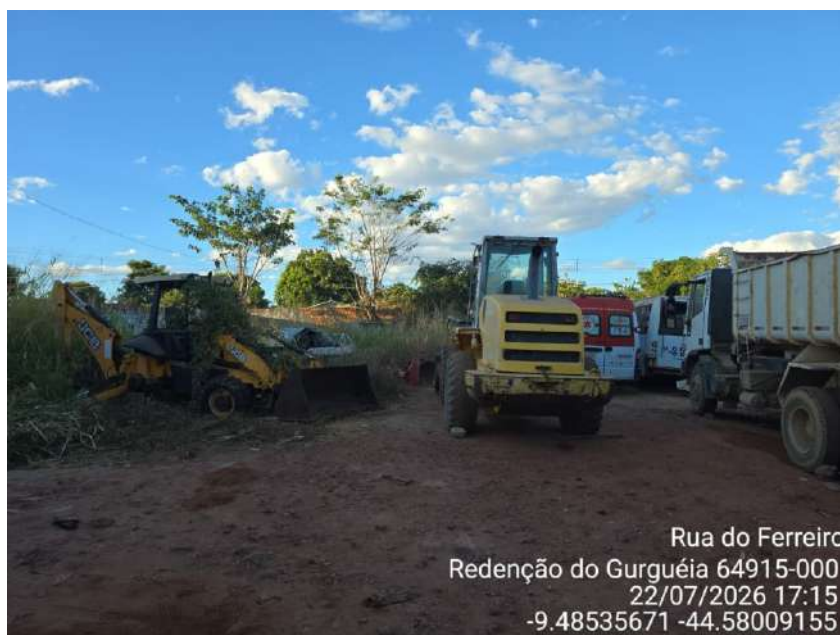
Figura 3: Construção do Centro Autismo
