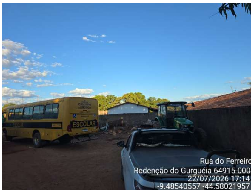
Figura 4: Construção do Centro Autismo
