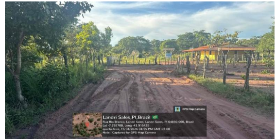
Foto 04: Trecho da LOC. MORADA DO SOL 02 a ser beneficiada
