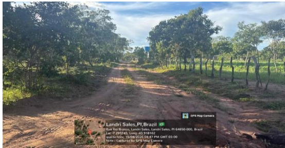
Foto 03: Trecho da LOC. MORADA DO SOL 02 a ser beneficiada
